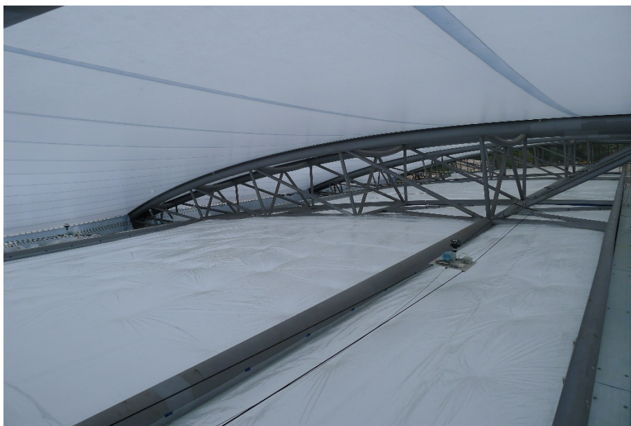
Abbildung 9: Membranzwischenraum Sporthalle Fürth. Quelle: HFT Stuttgart
